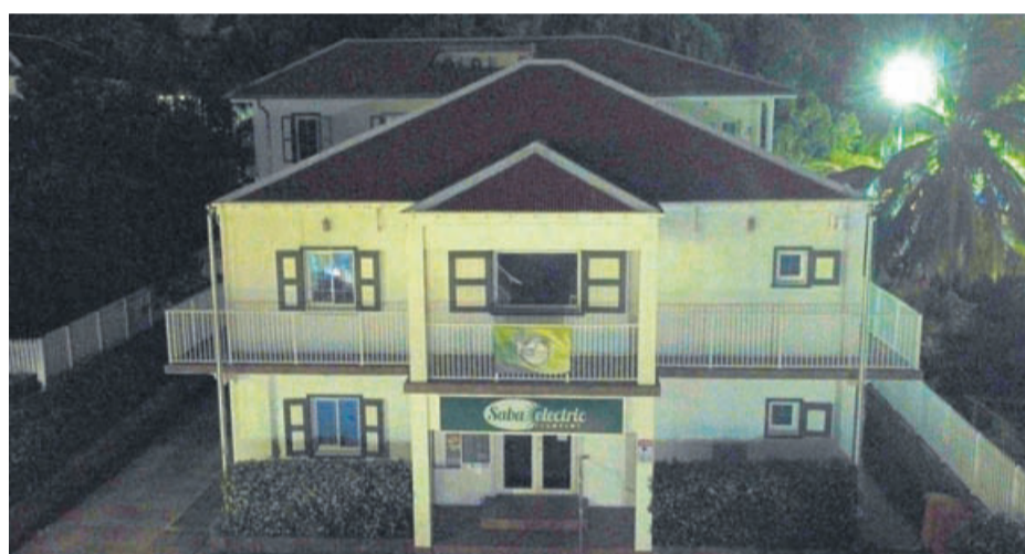
Saba Electric Company despues
